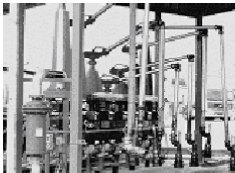
En los brazos de carga, conductos rígidos.
